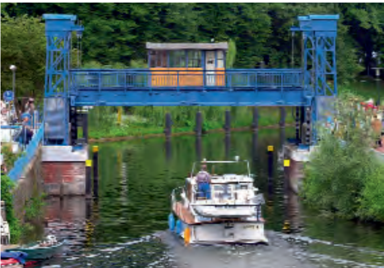
Fluss Elde, Hubbrücke in Plau am See
